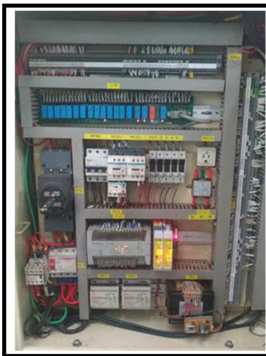
Figura 45: Painel elétrico da prensa PM17 após reforma
