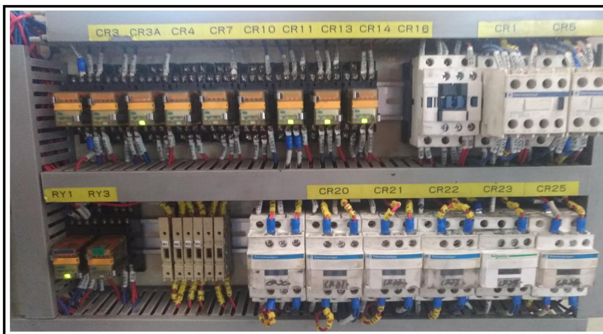
Figura 46: Comando elétrico redundante de acionamento da prensa PM17
